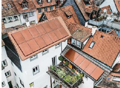
Photovoltaik ist in manchen Fällen auch auf historischen Dachlandschaften möglich, wie hier in der Konradgasse in der Niederburg. BILD: ELIÖ GEMH
